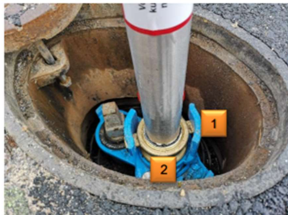
Aufgestelltes Standrohr
