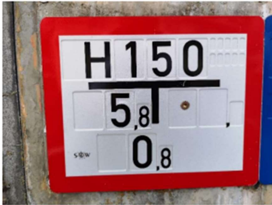
Hinweisschild zum Auffinden eines Hydranten Im Beispiel: 5,8 m nach links, 0,8 m Richtung Betrachter
