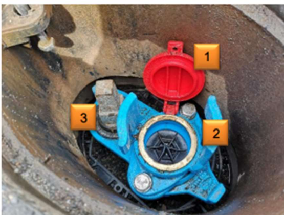
Geöffnete Hydrantenkappe
